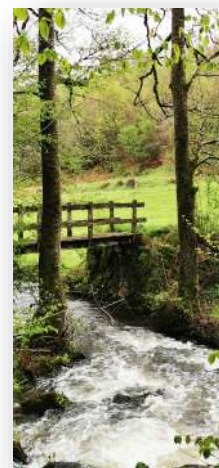
Pont de Brounhoux
