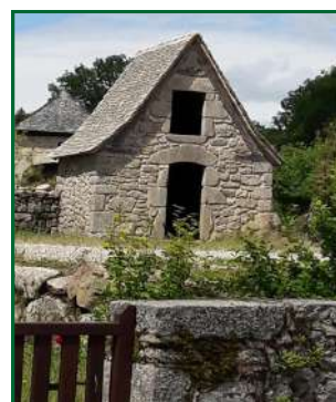
Le sécadou (restauration 2019-2020)
